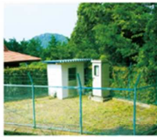
⑨ 東部第1配水池
