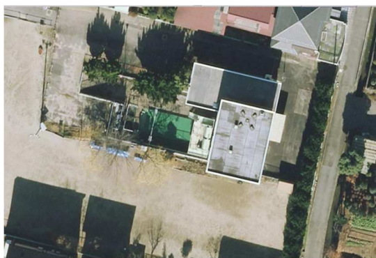
池添ポンプ場
