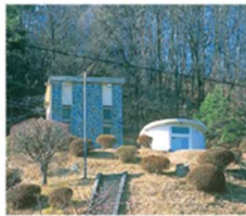
⑥ 高区(和田)配水池
