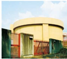
⑧ 北部第3配水池
