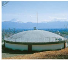
① 高区西(旧敷島)配水池
