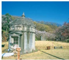
⑦ 中区(愛宕)配水池
