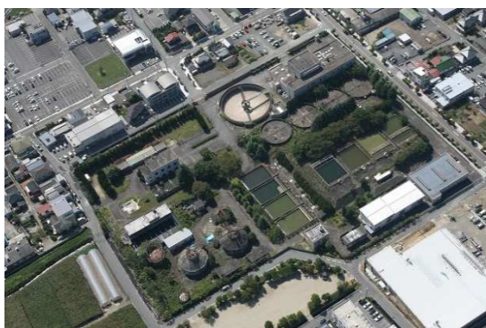
住吉中継ポンプ場
