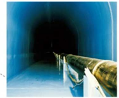
⑤ 湯村山トンネル配水池
