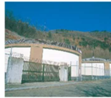
③ 羽黒配水池
