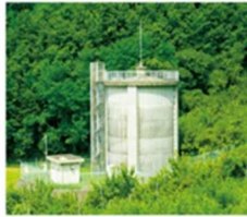
⑩ 南部第1配水池
