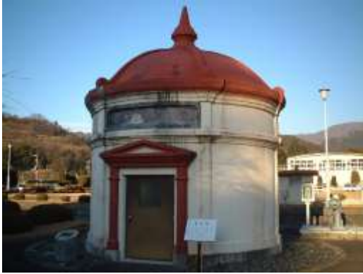
平瀬浄水場旧ろ過池整水井
