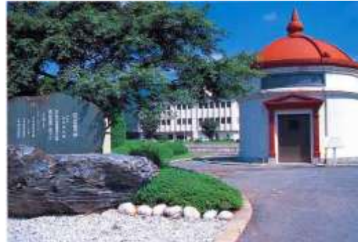
【平瀬浄水場】 甲府市平瀬町 437-3
