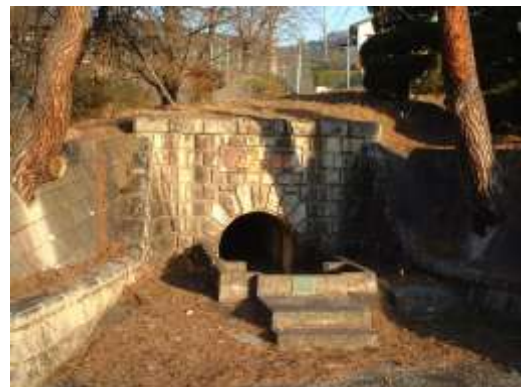
平瀬浄水場旧取水口門部
