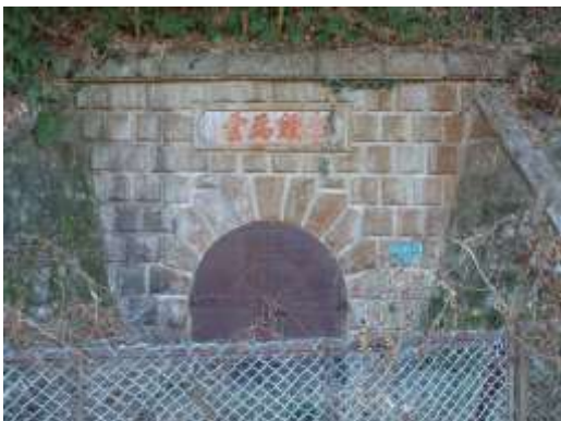
平瀬浄水場第2隧道上口
