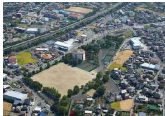
【昭和北方水源】 昭和町西条 2387
