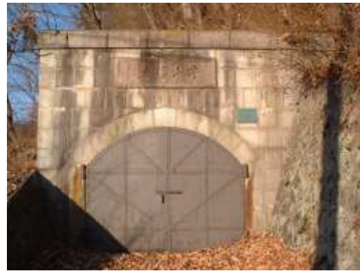
平瀬浄水場旧片山隧道下口
