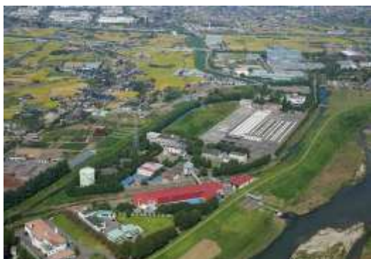
【甲府市浄化センター】 甲府市大津町 1645
