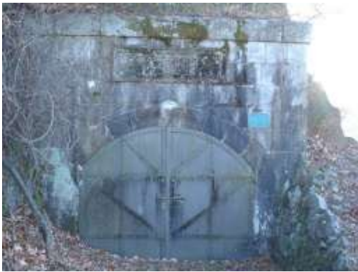
平瀬浄水場旧片山隧道上口
