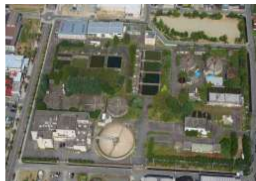
【住吉中継ポンプ場】 甲府市住吉 3 丁目 29-1
