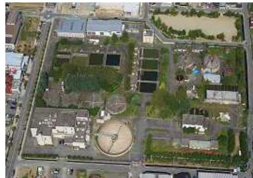
【住吉中継ポンプ場】 甲府市住吉 3 丁目 29-1
