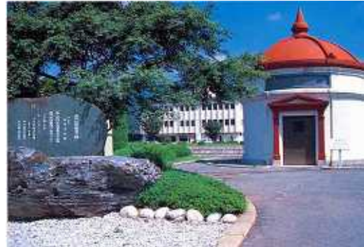
【平瀬浄水場】 甲府市平瀬町 437-3
