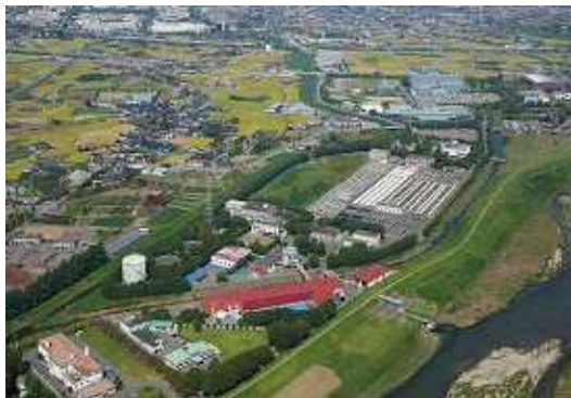
【甲府市浄化センター】 甲府市大津町 1645
