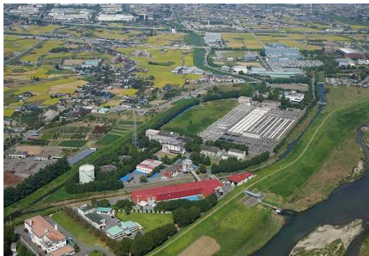
【甲府市浄化センター】 甲府市大津町 1645
