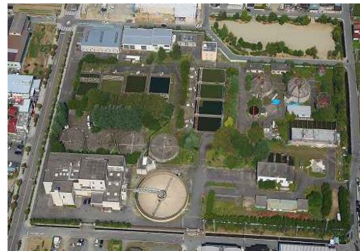
【住吉中継ポンプ場】 甲府市住吉三丁目 29-1
