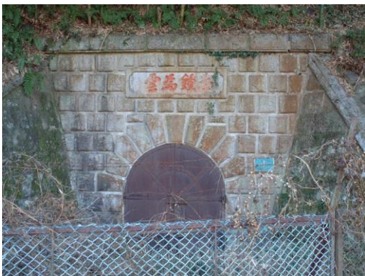
平瀬浄水場第2隧道上口
