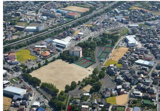
【昭和北方水源】 中巨摩郡昭和町西条 2387
