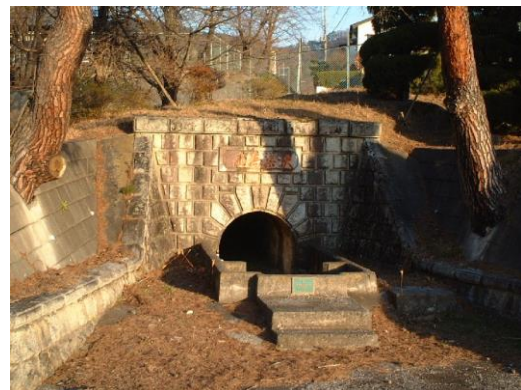
平瀬浄水場旧取水口門部
