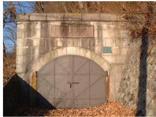
平瀬浄水場旧片山隧道下口
