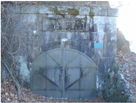
平瀬浄水場旧片山隧道上口
