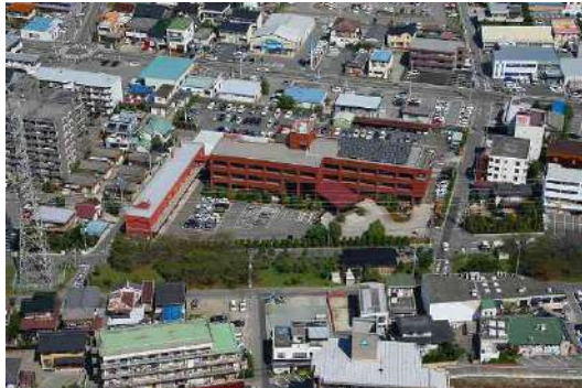
【甲府市上下水道局庁舎】 甲府市下石田二丁目 23 番 1 号
