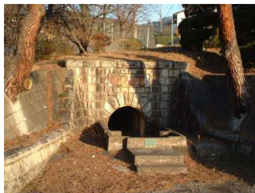
平瀬浄水場旧取水口門部
