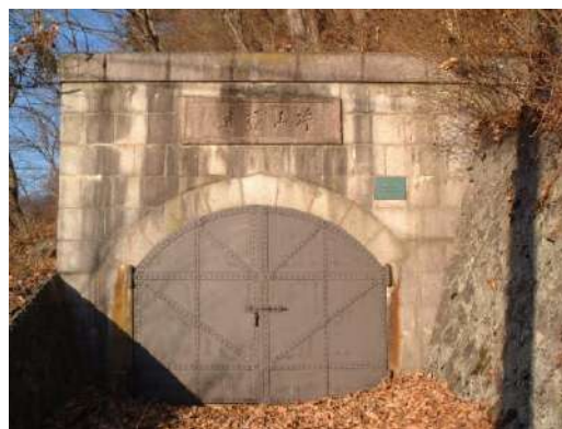
平瀬浄水場旧片山隧道下口
