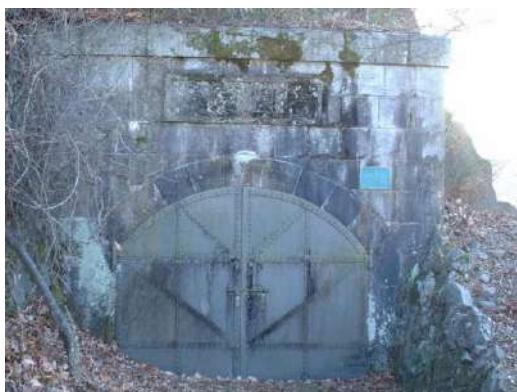
平瀬浄水場旧片山隧道上口
