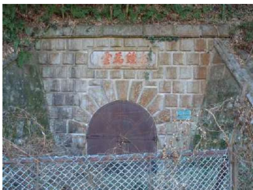
平瀬浄水場第2隧道上口
