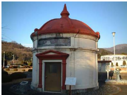
平瀬浄水場旧ろ過池整水井
