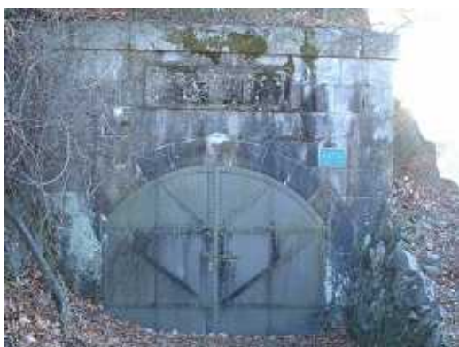
平瀬浄水場旧片山隧道上口
