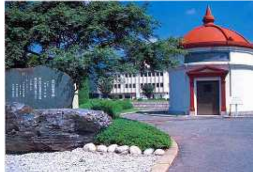
【平瀬浄水場】 甲府市平瀬町 437-3
