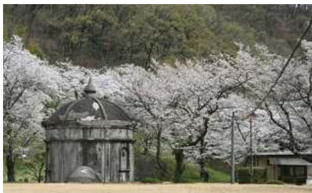
愛宕山中区配水場 施設開放 (3月26～4月7日)
