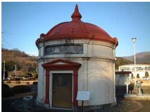
平瀬浄水場旧ろ過池整水井
