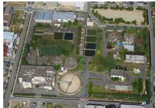
【住吉中継ポンプ場】 甲府市住吉 3 丁目 29-1
