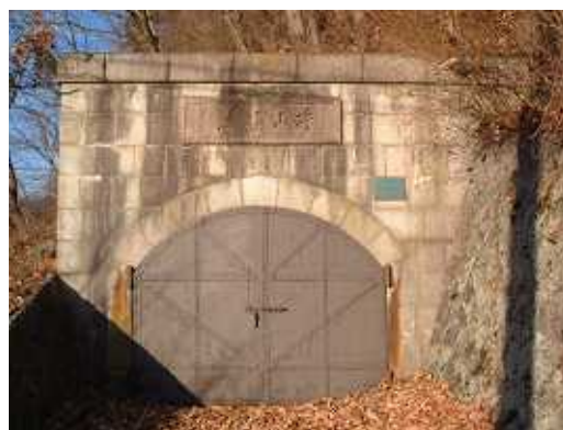
平瀬浄水場旧片山隧道下口
