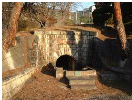
平瀬浄水場旧取水口門部
