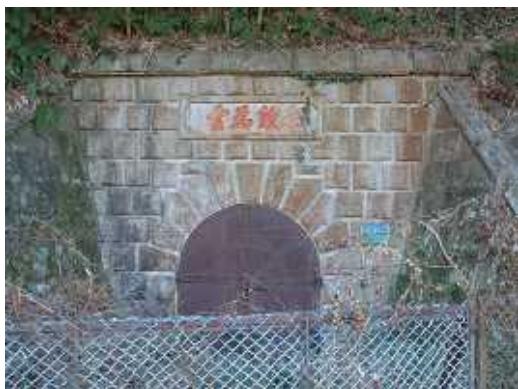
平瀬浄水場第2隧道上口
