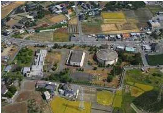
【昭和浄水場】 中巨摩郡昭和町西条 1413
