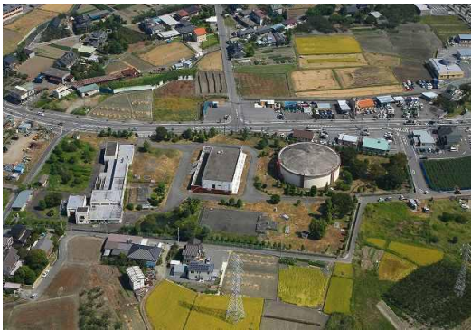
【昭和浄水場】 中巨摩郡昭和町西条 1413
