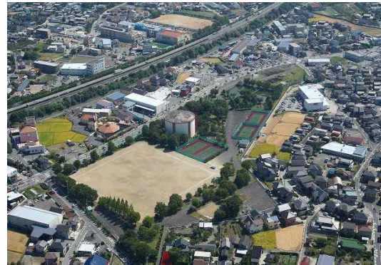
【昭和北方水源】 昭和町西条新田 600
