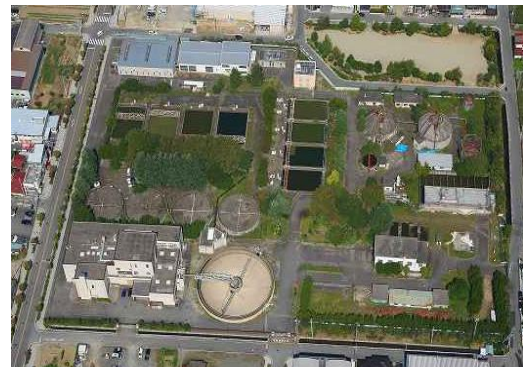
【住吉中継ポンプ場】 甲府市住吉 3 丁目 29-1
