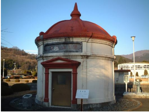
平瀬浄水場旧ろ過池整水井 築造年：大正2年 登録原簿登録日：平成9年7月15日
