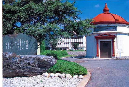
【平瀬浄水場】 甲府市平瀬町 437-3
