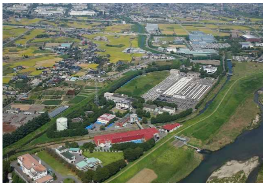
【甲府市浄化センター】 甲府市大津町 1645
