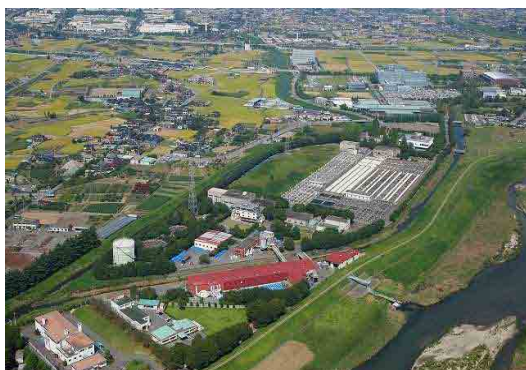
【甲府市浄化センター】
