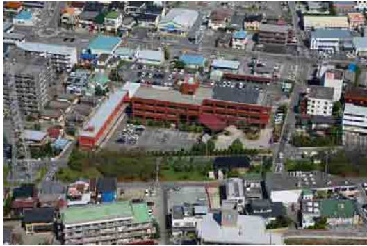
【甲府市上下水道局庁舎】
