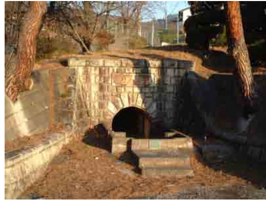
平瀬浄水場旧取水口門部 築造年：大正2年 登録原簿登録日：平成10年9月2日
