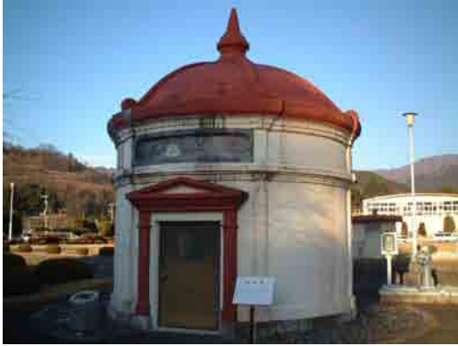
平瀬浄水場旧ろ過池整水井 築造年：大正2年 登録原簿登録日：平成9年7月15日
