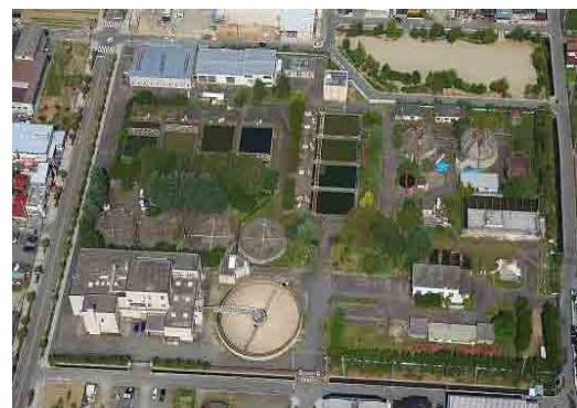
【住吉中継ポンプ場】
