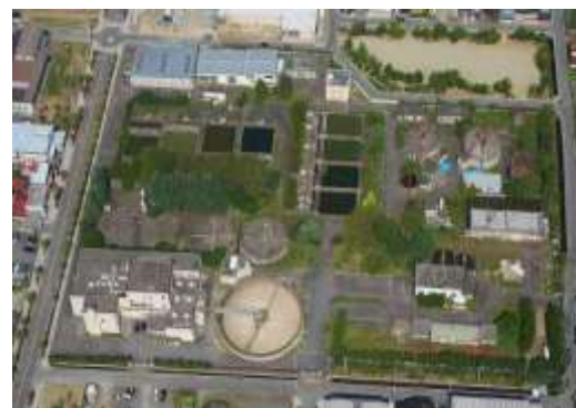
【住吉中継ポンプ場】 甲府市住吉三丁目 28-1
