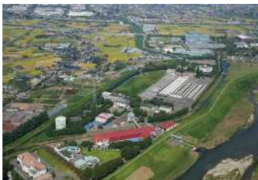
【甲府市浄化センター】 甲府市大津町 1645
