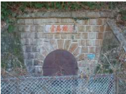
平瀬浄水場第2隧道上口
