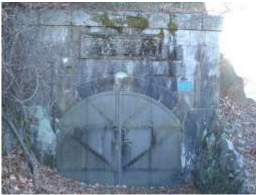
平瀬浄水場旧片山隧道上口
