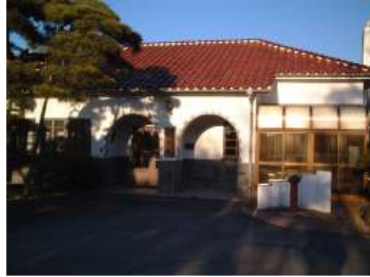
平瀬浄水場旧事務所
