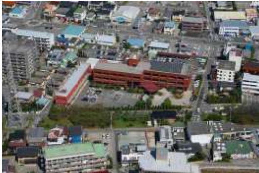
【甲府市上下水道局庁舎】 甲府市下石田二丁目 23-1
