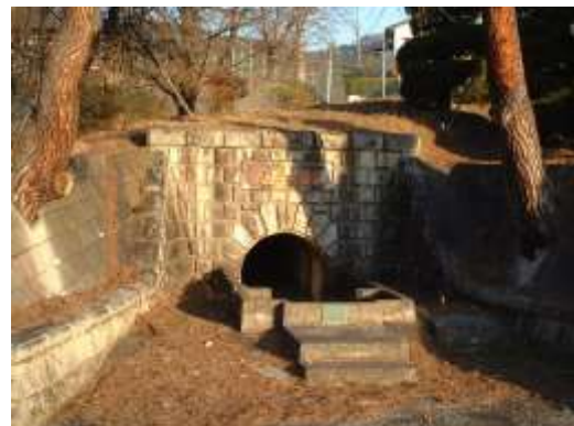
平瀬浄水場旧取水口門部
