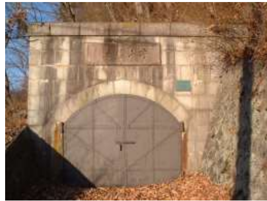
平瀬浄水場旧片山隧道下口
