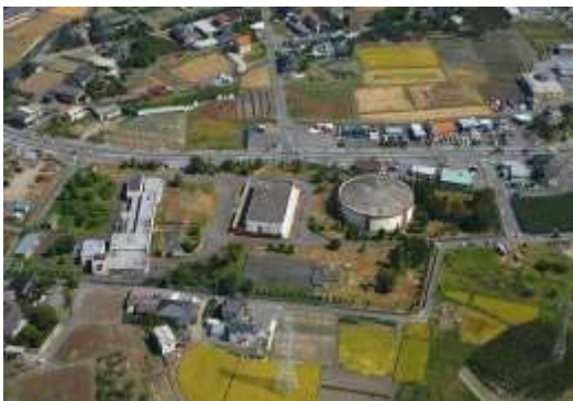
【昭和浄水場】 中巨摩郡昭和町西条 1413
