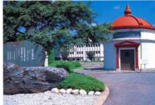
【平瀬浄水場】 甲府市平瀬町 437-3
