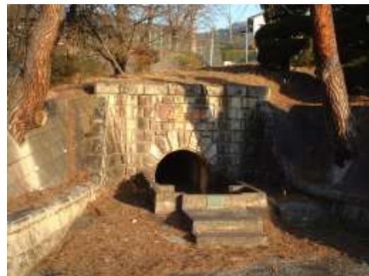
平瀬浄水場旧取水口門部
