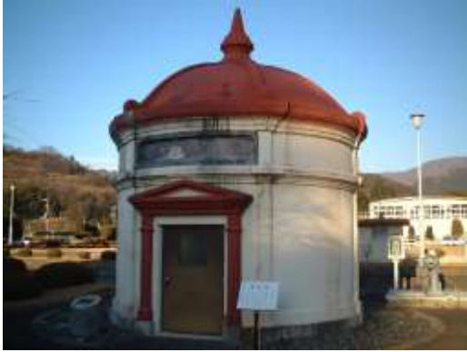
平瀬浄水場旧ろ過池整水井
