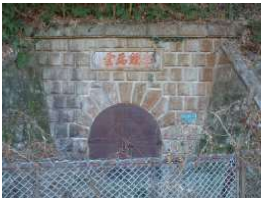
平瀬浄水場第2隧道上口
