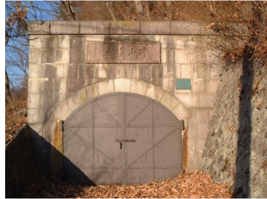
平瀬浄水場旧片山隧道下口
