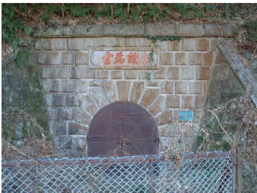
平瀬浄水場第2隧道上口
