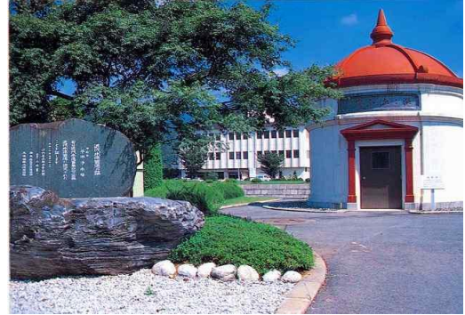
【平瀬浄水場】 甲府市平瀬町 437-3
