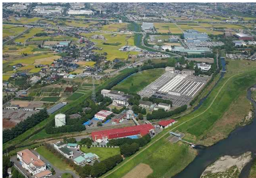
【甲府市浄化センター】 甲府市大津町 1645
