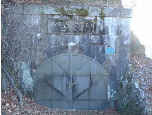
平瀬浄水場旧片山隧道上口
