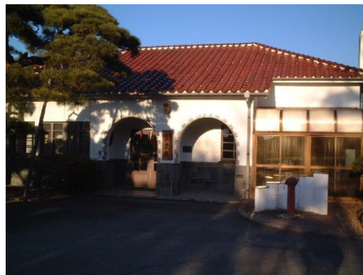
平瀬浄水場旧事務所
