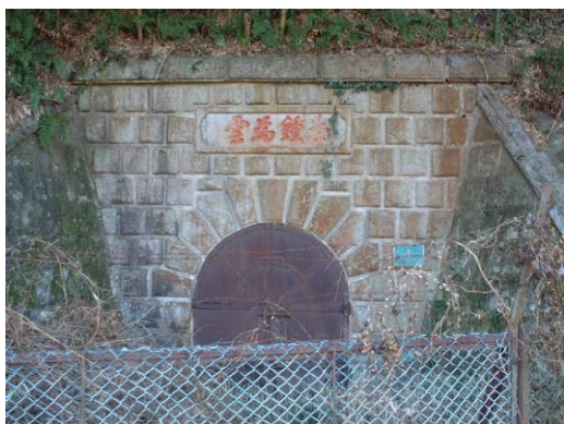
平瀬浄水場第2隧道上口
