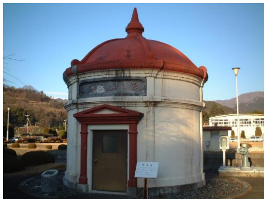
平瀬浄水場旧ろ過池整水井
