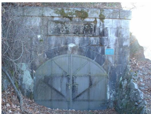
平瀬浄水場旧片山隧道上口
