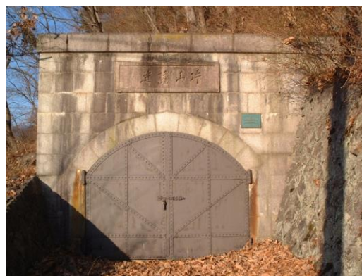
平瀬浄水場旧片山隧道下口
