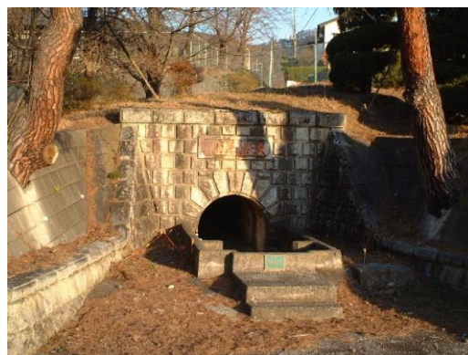
平瀬浄水場旧取水口門部
