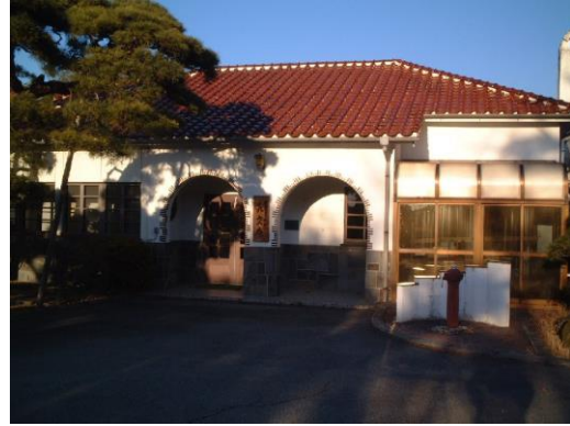
平瀬浄水場旧事務所
