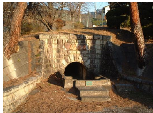
平瀬浄水場旧取水口門部
