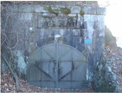
平瀬浄水場旧片山隧道上口
