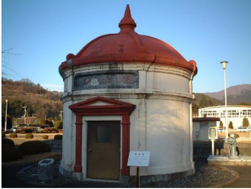
平瀬浄水場旧ろ過池整水井
