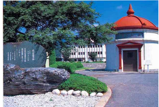
【平瀬浄水場】 甲府市平瀬町 437 番地 3
