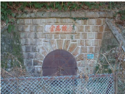
平瀬浄水場第2隧道上口
